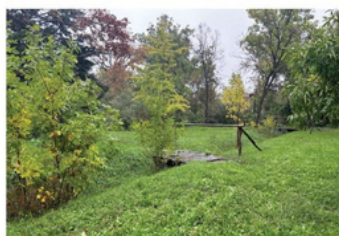
A tóhoz csatlakozó gyepes árok a tó betonmedre miatt nem tudja betölteni funkcióját
