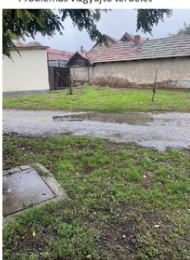
Nem megfelelő leítésirányok
