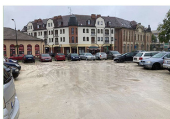
Zoltán u. melletti parkoló - Burkolat, vízkezelés
