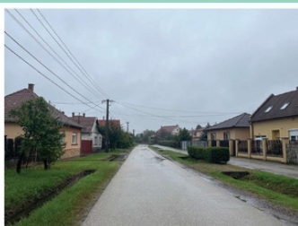
Az úttest és a járda között kétoldalt megjelenik a vízelvezető árok és az autófeljárók vizet át nem eresztő burkolatokkal.
