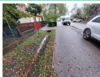
A meglévő árok rendszere sok helyen nem megfelelő lejtési viszonyokkal és összekötöttséggel rendelkezik.
